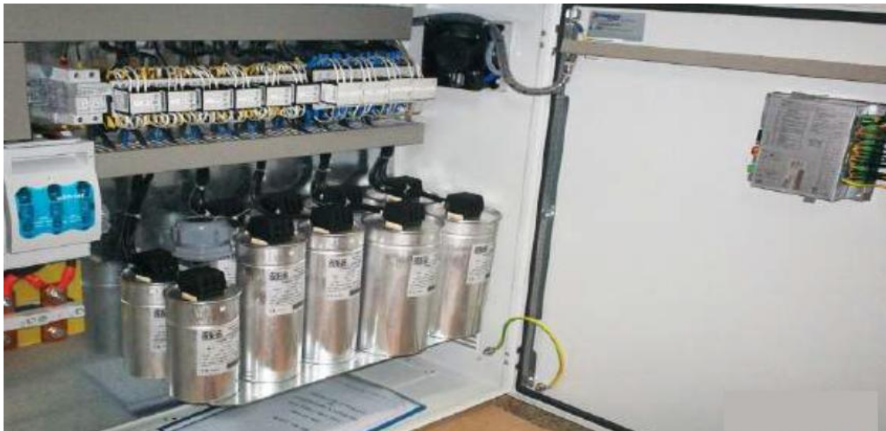
Foto batteria di condensatori per rifasamento
